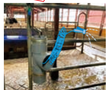
図2 水道配管と洗浄シャワーを牛舎内に複数設置
